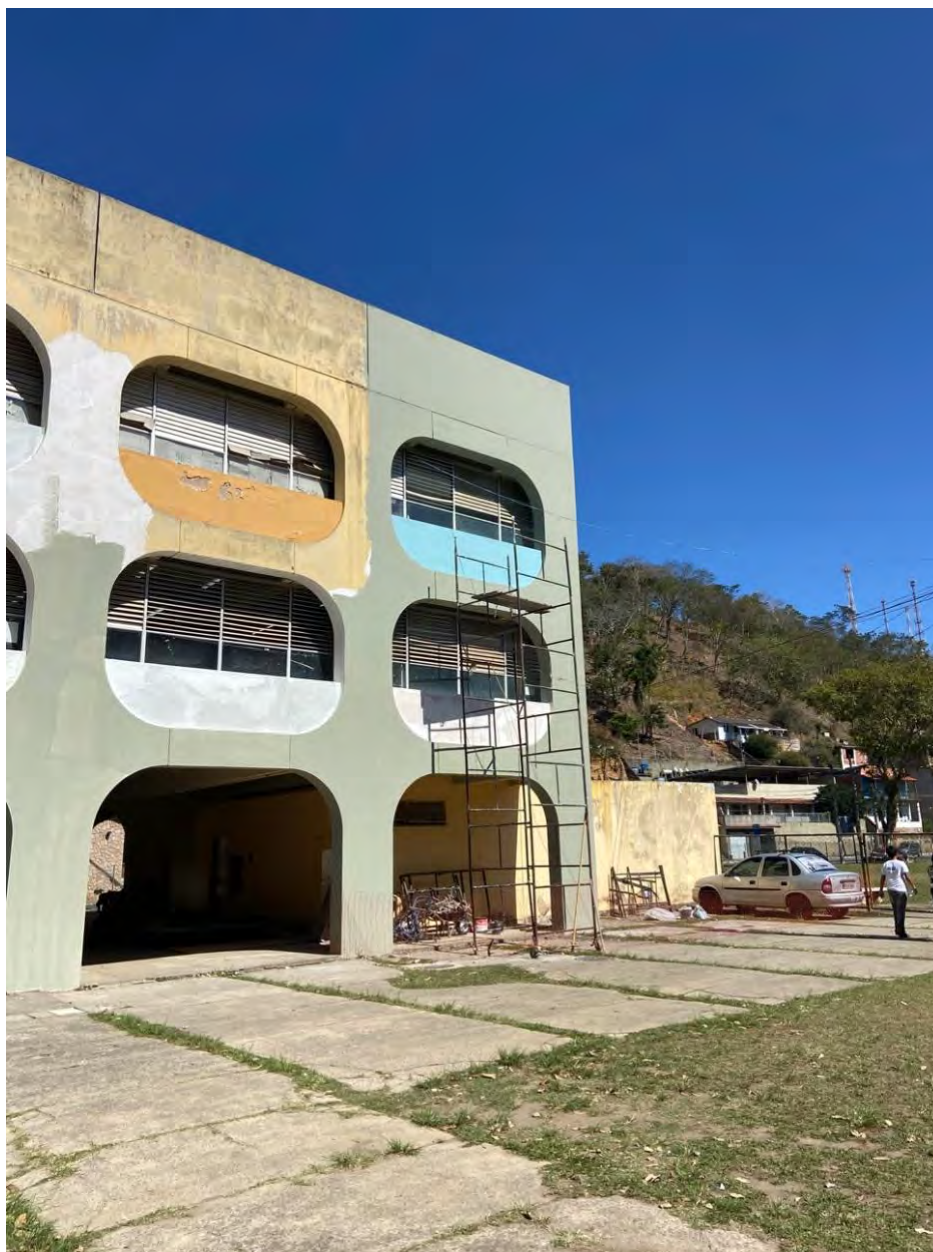
Figura 17: Início da nova pintura na fachada do CIEP 158 – Professora Margarida Thompson. Piraí-RJ. 2022.
