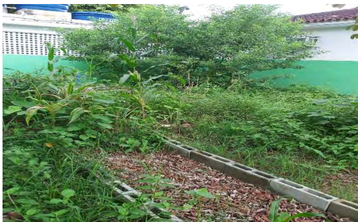
Figura 7 – Canteiro construído em 2020
