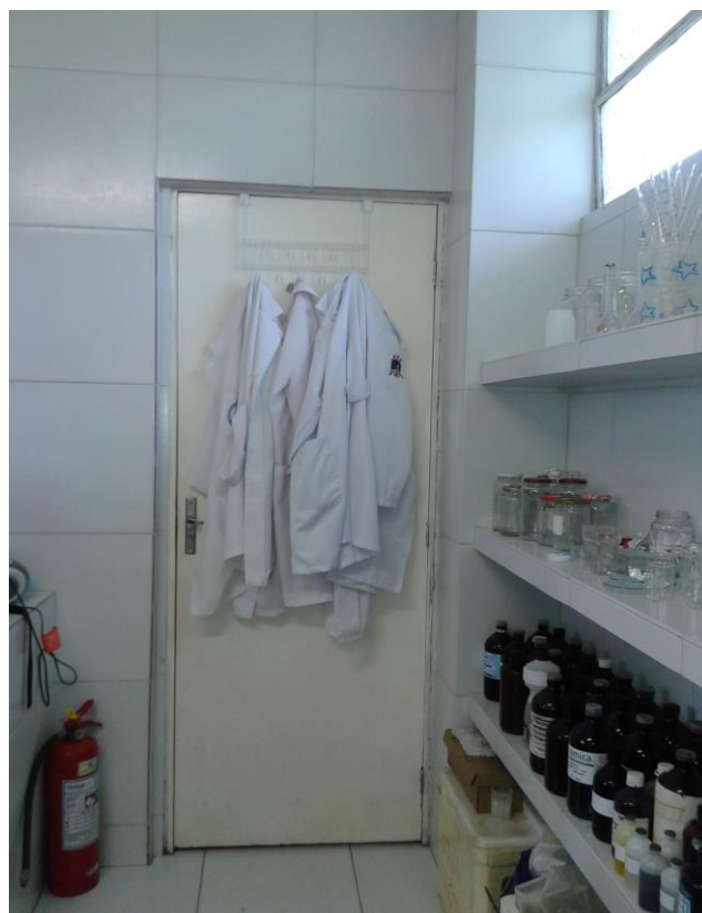
Figura 13 – Único extintor para os três laboratórios localizado no laboratório B
