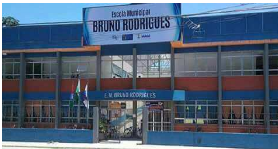
Figura 6 – Fachada atual da escola
