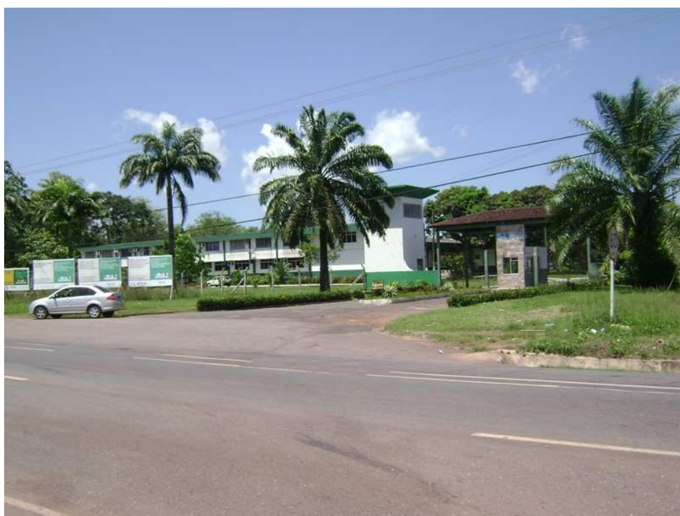
Figura 3: Fotografia da visão de frente da entrada da escola, as margens da BR 316 – Km 63. Castanhal – Pará. Ao fundo vista do prédio administrativo.
