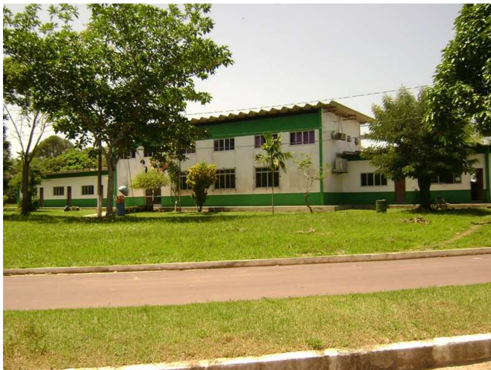
Figura 9: fotografia da fachada do prédio da atual Biblioteca, onde acima funciona alguns setores de acompanhamento aos educandos. Aos lados alojamentos de educandos (as).
