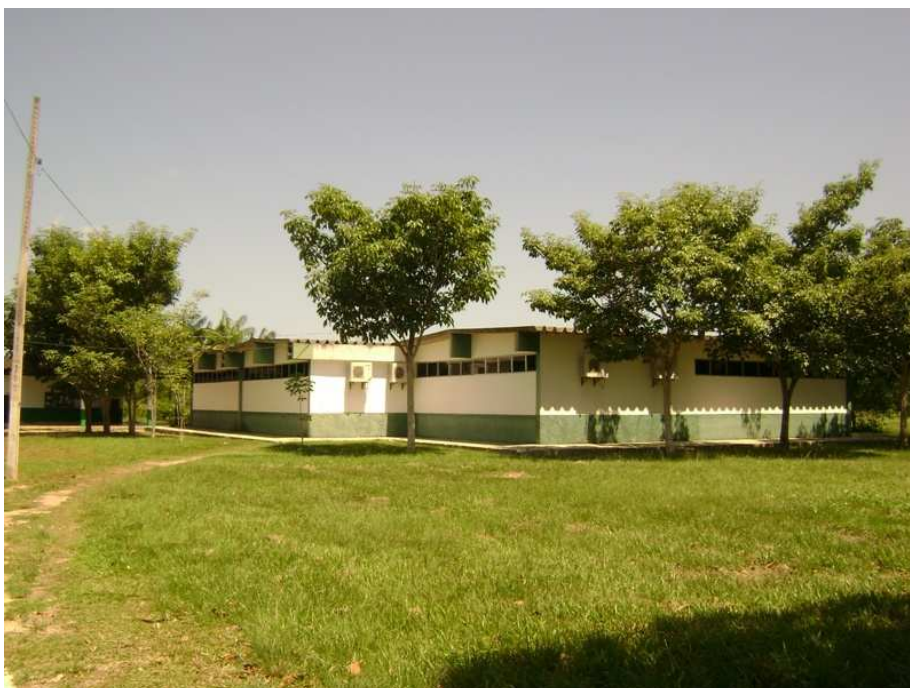
Figura 7: Fotografia da parte dos fundos dos blocos de aulas.
