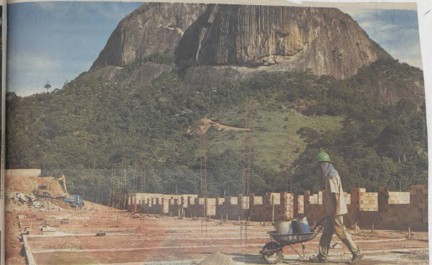
Obra do condomínio Recanto das Águas, que está sendo construído pelos fiéis da igreja evangélica Tabernáculo Vitória em Ecopora
