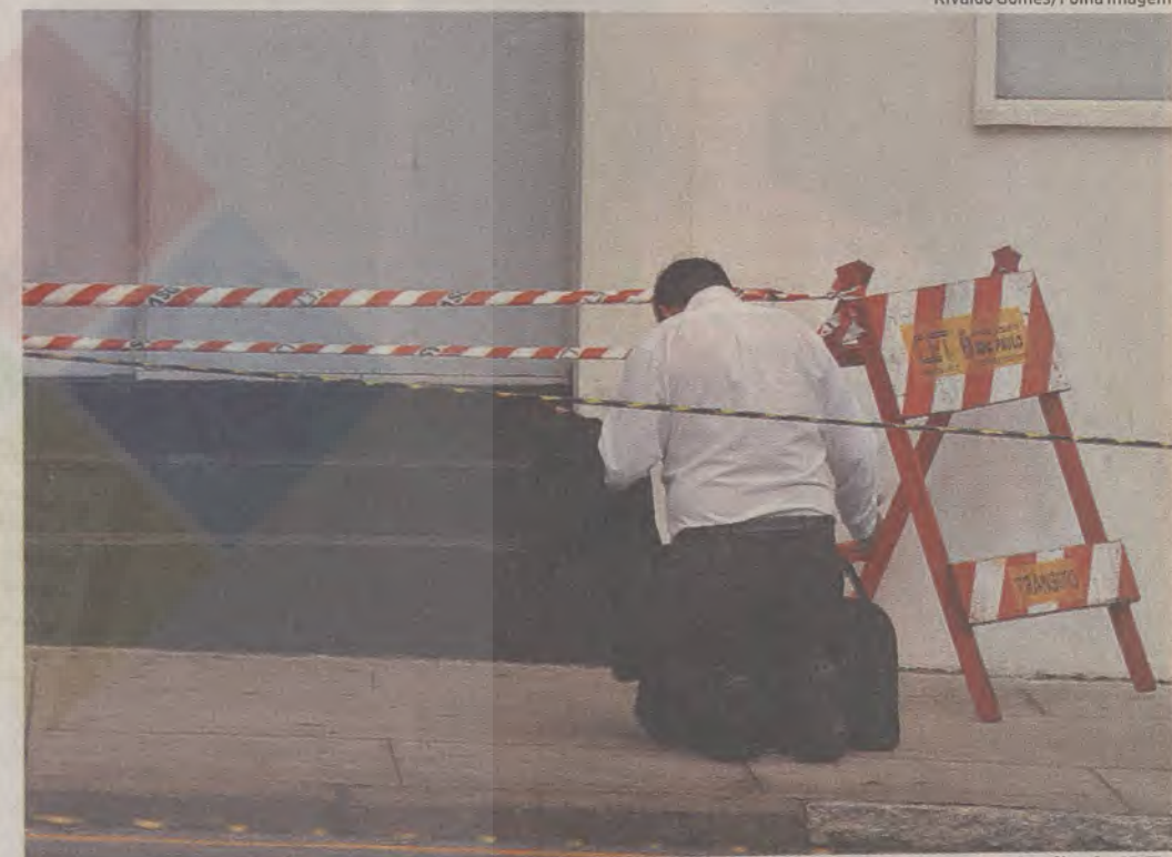
Fiel ora em frente a sede da igreja cujo teto desabou; Renascer não seguiu recomendação do IPT
