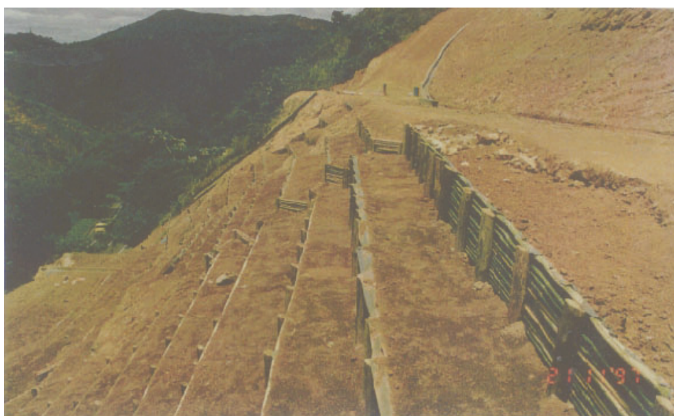
Figura 3 – Talude rodoviário preparado para a revegetação. Detalhe das obras de retaludamento, contenção e drenagem.
