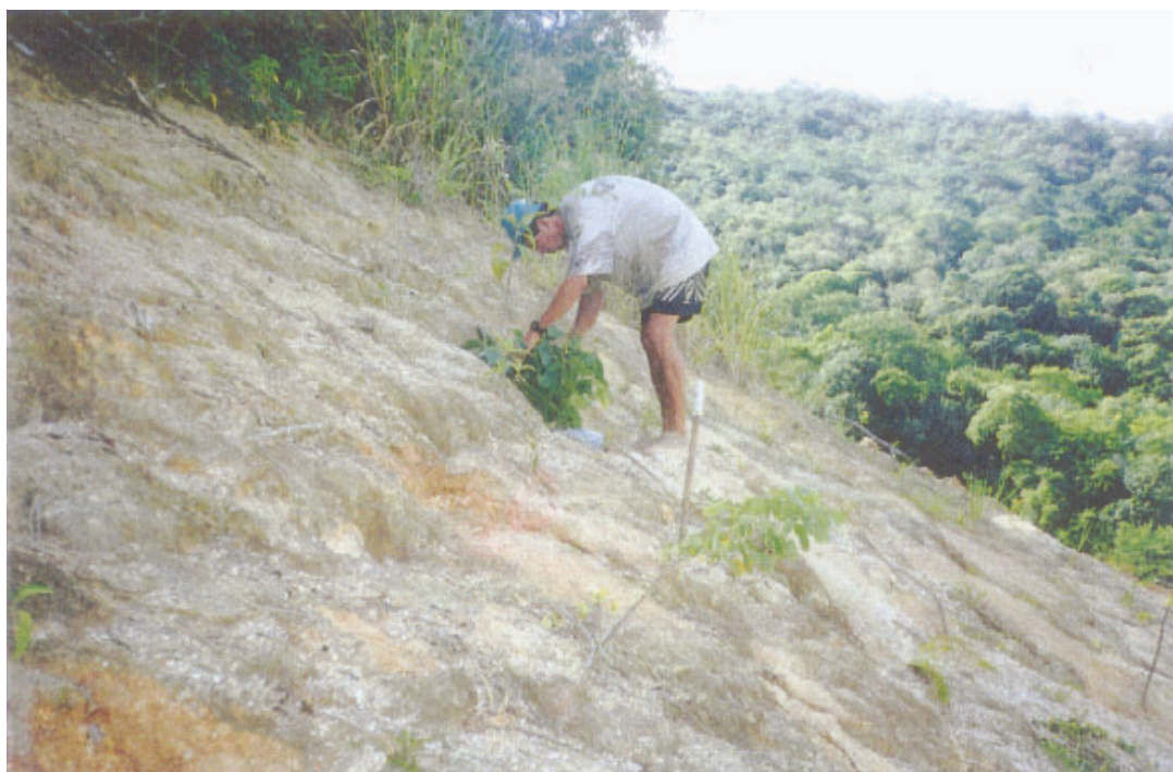
Figura 16 – Instalação das almofadas em talude de corte.
