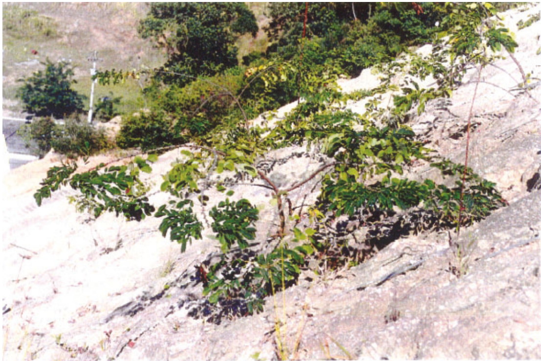
Figura 28 - Aspecto típico de sabiá plantado em talude de corte.
