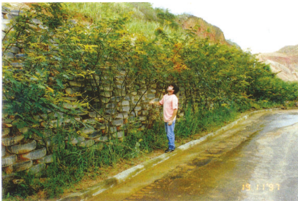
Figura 4 – Uso combinado de medida física (muro de pneus) e medida biológica (plantio de Mimosa pelita ) para proteção e estabilização de talude. Saibreira da EFUMC, bairro de Jacarepaguá, município do Rio de Janeiro, em novembro de 1997.
