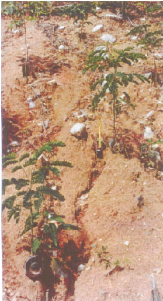
Figura 31 – A. lebbeck (à esquerda) e A. angustissima plantadas em talude de aterro com o auxílio de fixador de bambu.
