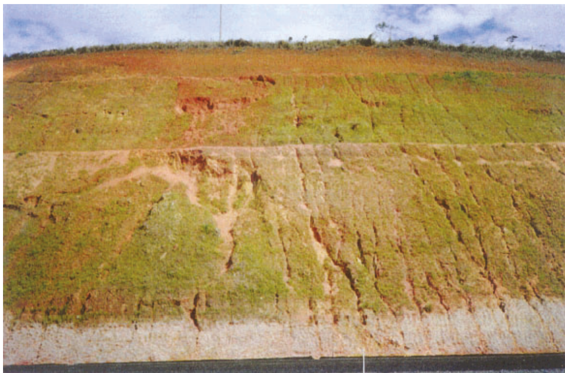
Figura 5 - Talude rodoviário hidrossemeado, exibindo intenso processo erosivo e sinais de instabilidade. Rodovia BR-101, município de Itaboraí - RJ, em junho de 1996.
