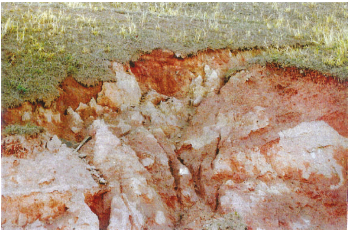
Figura 8 – Movimento de massa em talude rodoviário revegetado por espécies herbáceas de enraizamento superficial. Município de Águas de Lindóia – SP, 1996.
