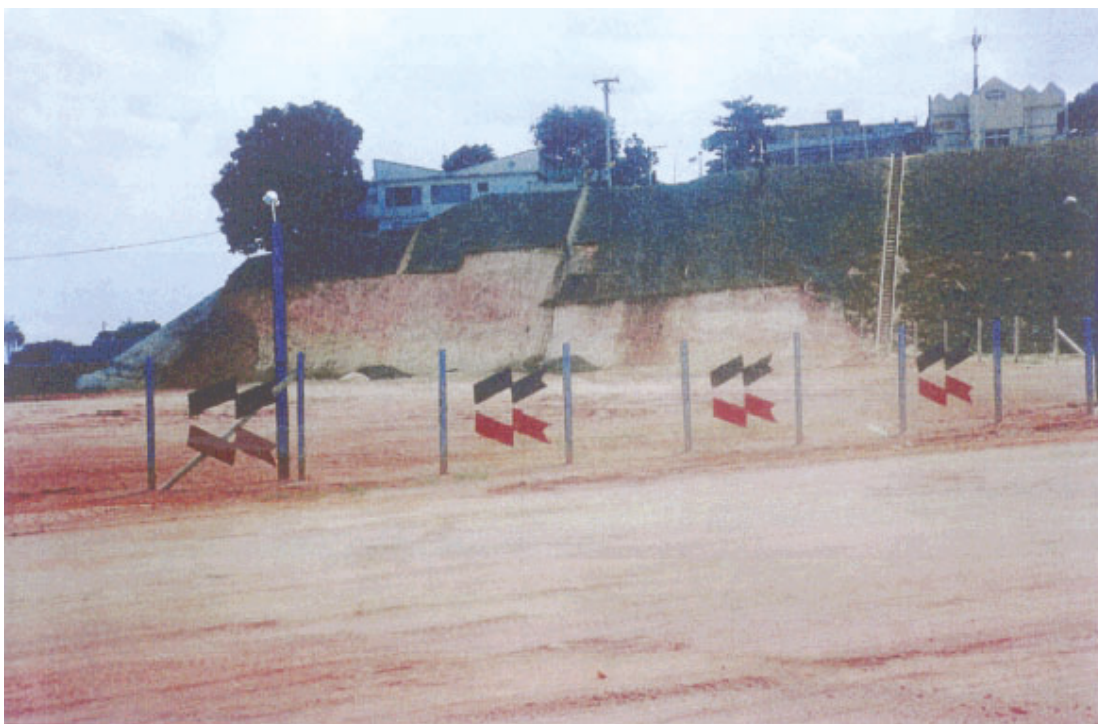
Figura 6 - Revegetação de talude através do plantio de grama em placas. Rodovia Presidente Dutra, no município de Nova Iguaçu – RJ.
