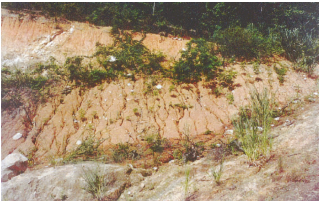
Figura 41 – Regeneração natural e o plantio em talude de aterro.
