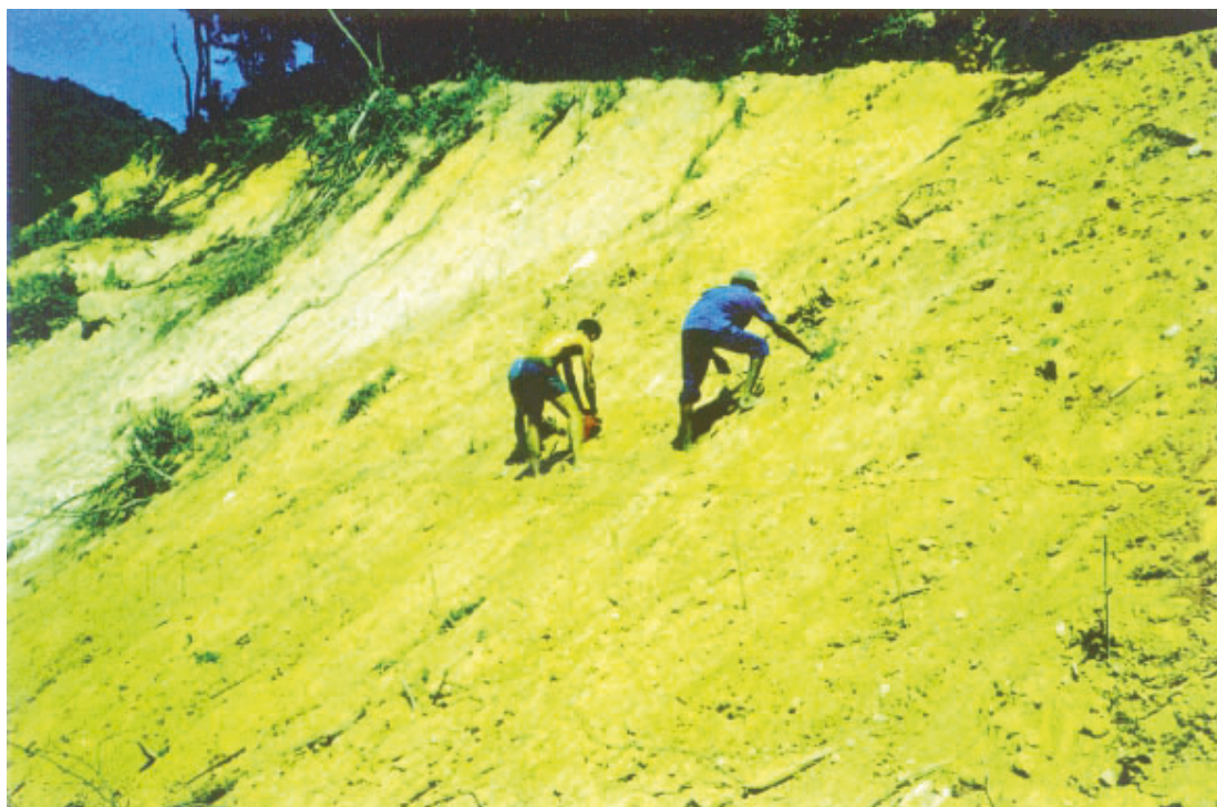
Figura 30 - Plantio em talude de aterro.
