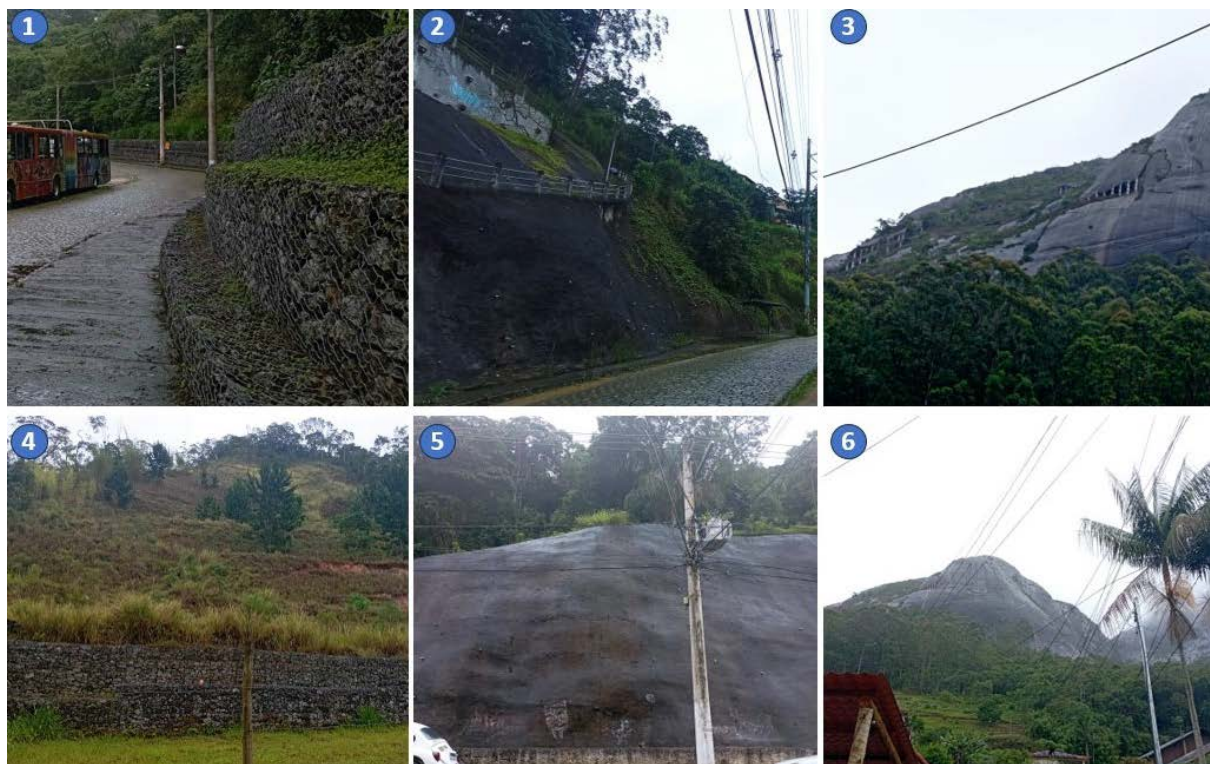
Composição 7 - Dispositivos de Contenção em encostas e margens de corpos d'água Nova Friburgo em detalhe. Figura 1 - Detalhe da contenção tipo gabião no bairro Duas Pedras. Figura 2 - Muro de contenção e tirantes. Figura 3 - Detalhe da estabilização de parede rochosa com aço. Figura 4 - Detalhe da contenção tipo gabião no centro, interseção da Rua Augusto Spinelli com Rua Christina Ziede. Figura 5 - Muro de arrimo com drenagem. Figura 6 - Parede rochosa estabilizada com aço danificada em 2011. Fonte: Levantamento fotográfico realizado pela autora.
