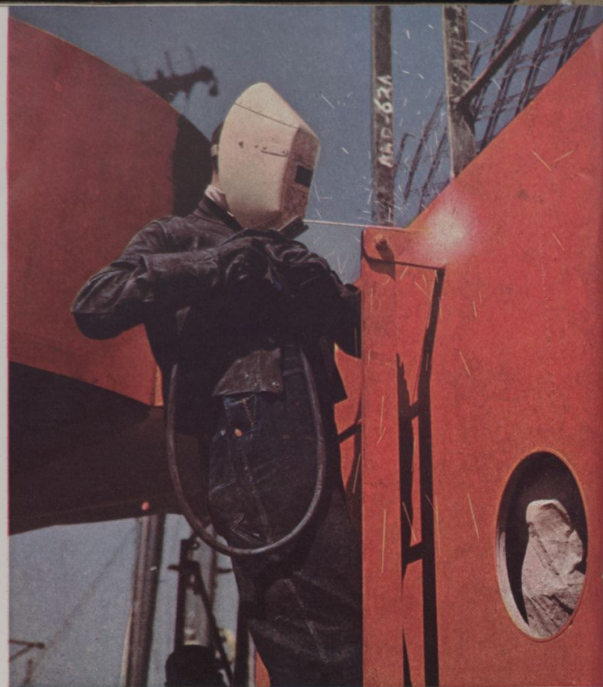
A soldagem tem abreviado consideravelmente a construção de navios mercantes. Do batimento da quilha à entrega do navio, esses cargueiros são construídos em 30 dias, em vários estaleiros
