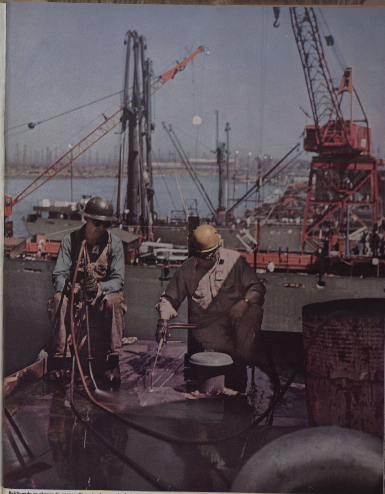
Retificando as chapas do convés. Os navios transportarão tropas e abastecimentos das Nações Unidas e materiais de empréstimos e arrendamentos para os aliados
