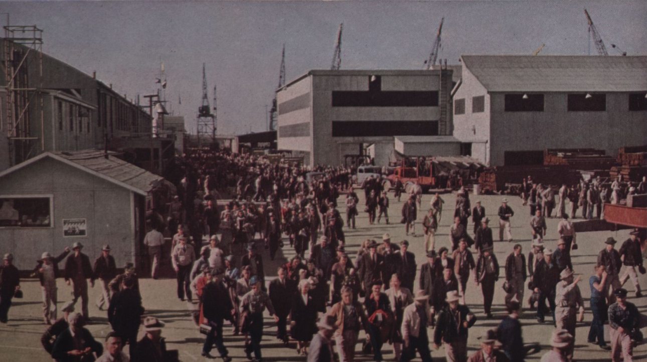
Vinte mil operários passam pelos portões deste estaleiro, na Califórnia, trabalhando dia e noite. O comércio civil tem apenas um sétimo dos navios construídos
