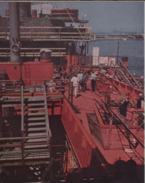
Após o lançamento, os operários dão a última de mão num cargueiro de 10.500 toneladas. Em 18 meses, mais de mil foram construídos nos EE. UU.
