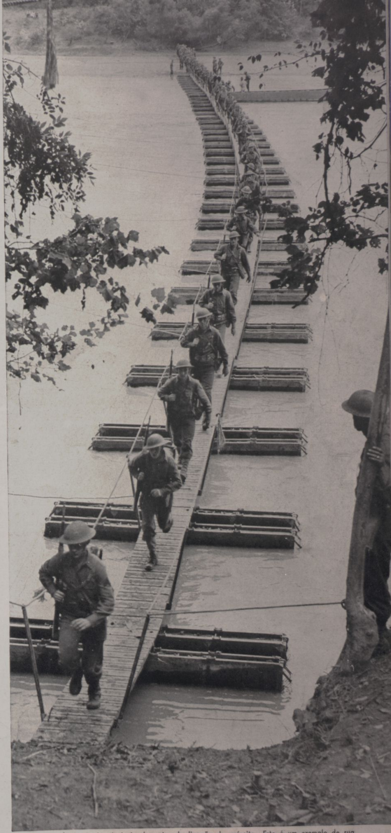
Os pontoneiros são inestimáveis elementos de ligação do exército. Este é um exemplo de sua prodigiosa habilidade na construção rápida duma ponte para ser utilizada por tropas de infantaria
