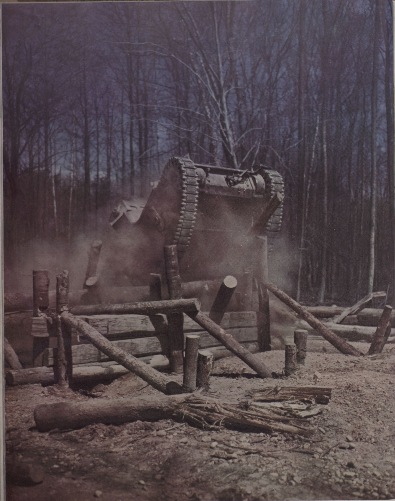
A armadilha para tanques é um feito de engenharia militar. Toras dispostas nesta posição empinam o tanque no rasto das rodas, tornando-o inútil
