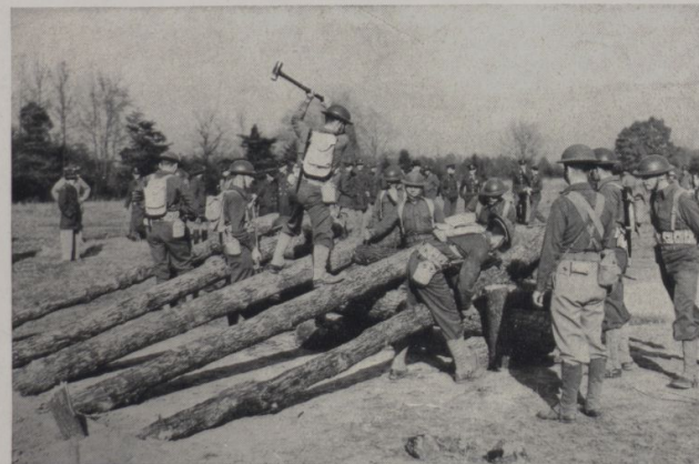
A construção de armadilhas para tanques é um verdadeiro feito de engenharia militar. As mais eficazes são construídas com grandes toras de madeira, devidamente inclinadas
