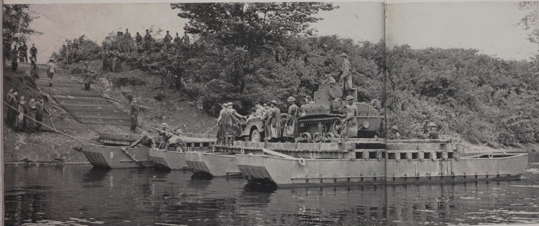
Pontoneiros do 24º Batalhão constroem enorme balsa sobre pontões, destinada a travessia de equipamento pesado de tropas mecanizadas. O terreno acidentado da margem oposta recebeu cobertura provisória de resistentes telas de aço
