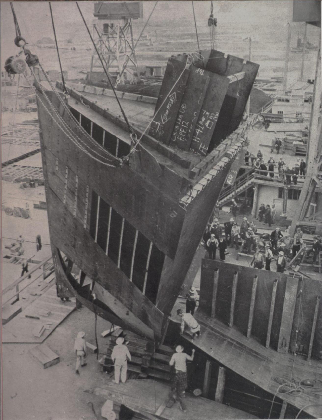
Modernos métodos de construção naval abreviam o trabalho: a proa completa de um navio cargueiro é guindada para ser ajustada e soldada ao resto do casco
