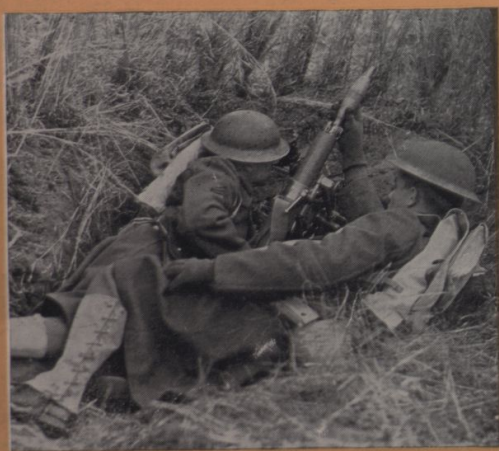
O uso do morteiro de trincheira, arma eficaz de curto alcance, é ainda recurso adotado pela infantaria. Seu projétil é introduzido pela boca da peça.
