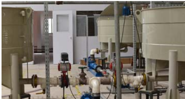
Figura 3.13 – Válvulas borboleta.
